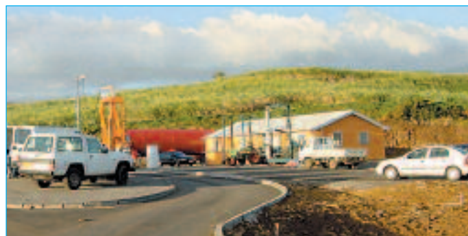
Les bâtiments actuels du CTICS à la plateforme des Tamarins, autour desquels prendra place un des 5 futurs Pôles Canne
